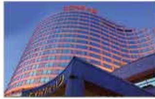
AKSOY İNŞAAT - CONRAD OTEL
