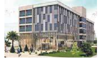
KOÇ İNŞAAT - İZMİR
